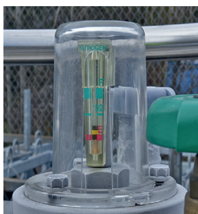
Määrämittari näyttää nesteen määrän säiliössä (kuva havainnollinen). Määrämittarit ovat erilaisia eri valmistajilla. Oikeanpuoleisessa kuvassa näkyy myös sulkuventtiilin kilpi.
