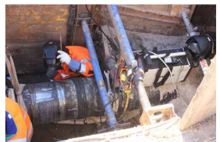
Onnistunut TIG-hitsaus laippaan putkiosuu- den ja palloventtiin välillä.
