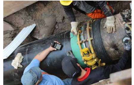
Kentän voimakkuusmittaus juuri en- nen hitsausta. Uutta putkikappaletta ei demagnetisoiu.
