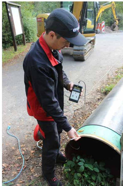
Kentän voimakkuuden tarkastus uudessa putkiosuudessa.
