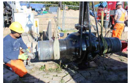
Uusi palloventtiili ennen asennusta.
